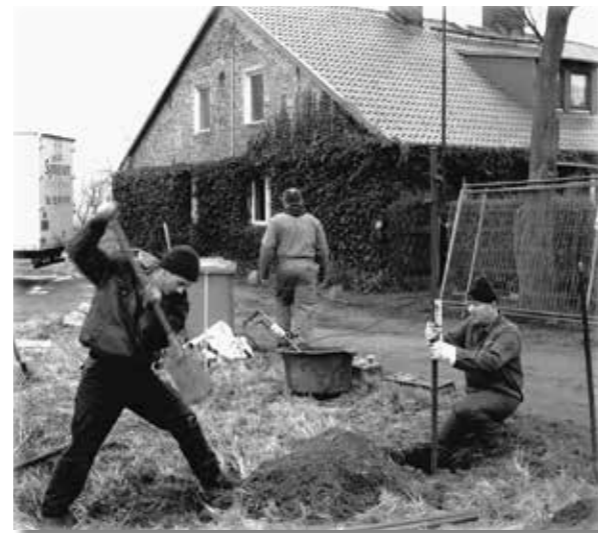
Umbauarbeiten am Urlaubs- und Wochenenddomizil in Steinhagen bei Stralsund.
