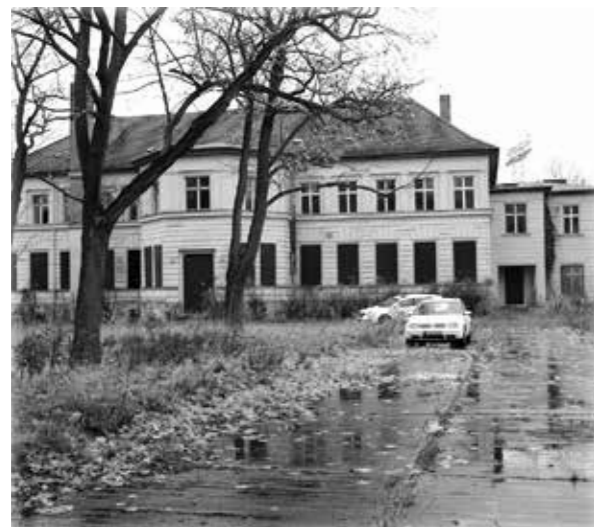
Umzug nach Berlin-Malchow und Beginn der umfangreichen Bau- und Sanierungsarbeiten auf dem alten Gutshofgelände.
