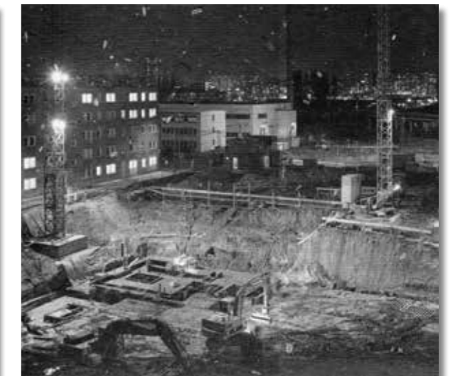
Baugrube für den Neubaukomplex Herzbergstraße in Berlin-Lichtenberg.
