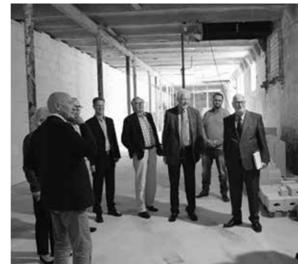
Das Kuratorium informiert sich über Baubeginn des Vorhabens „Umbau ehemaliger Kuhstall zu 12 Nachsorgewohnungen“.
