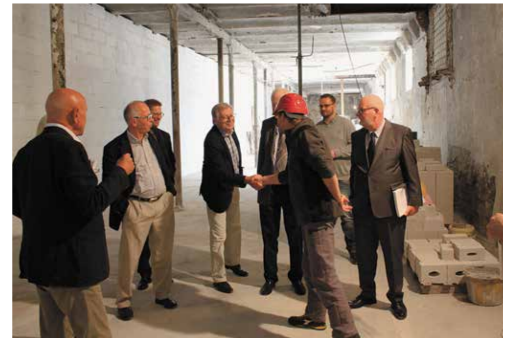
Anlässlich der gemeinsamen Sitzung von Kuratorium und Vorstand der STIFTUNG SYNANON im September 2019 informieren sich die Mitglieder des Kuratoriums über das gerade begonnene Bauvorhaben „Umbau eines ehemaligen Stallgebäudes zu Wohnen“. Es entstehen neben Wohnbereichen für Synanon-Bewohner auch 12 Wohnungen mit jeweils rd. 50 qm Wohnfläche für das Synanon-eigene Nachsorge-Angebot.
